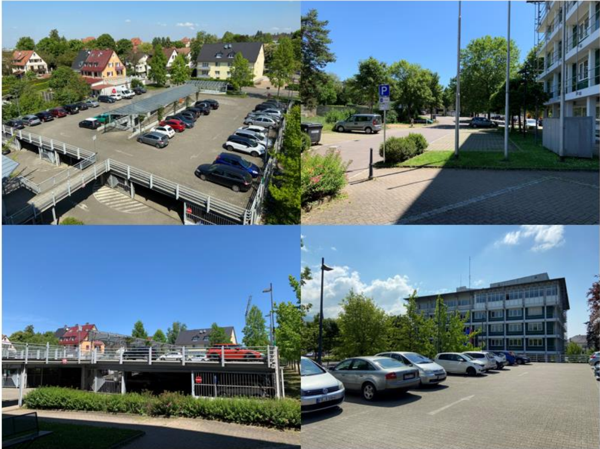
Abbildung 5: Außenbereich Parkhaus/Parkdeck und Rathaus
