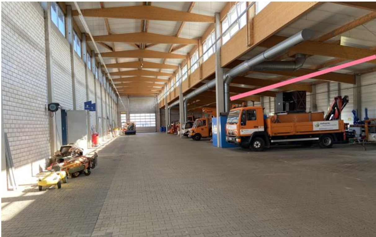
Abbildung 25: Installation der Kabelrinne
